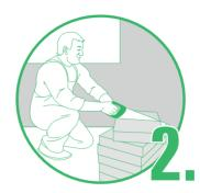
Zur Vorbereitung wird an der Decke als auch am Boden ein Trennstreifen zur mechanischen Entkopplung angebracht. Der Zuschnitt der CaSi-Wohnklimaplatte erfolgt mit einer Fuchsschwanzsäge.
