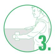
Auftragen der CaSi-Systems Silikatgrundierung, z.B. mit einem Quast oder einer Druckspritze, auf die CaSi-Systems Wohnklimaplatte Vorund Rückseite. Vor dem Verkleben: Grundierung der Rückseite. Vor dem Verputzen: Grundierung der Vorderseite.
